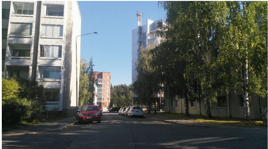
Näkymä Salhojankadulta. Suunnittelun kohteena oleva tontti on kuvan oikeassa laidassa, koivurivin takana. Taustalla näkyy terästalo.
